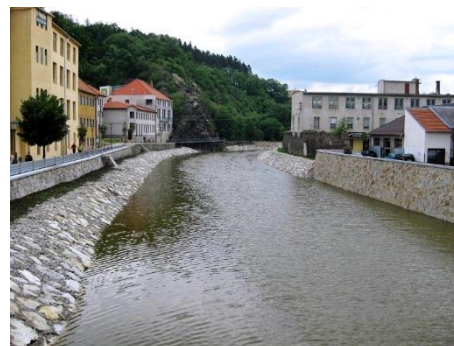
regulovaná řeka v betonovém korytě
